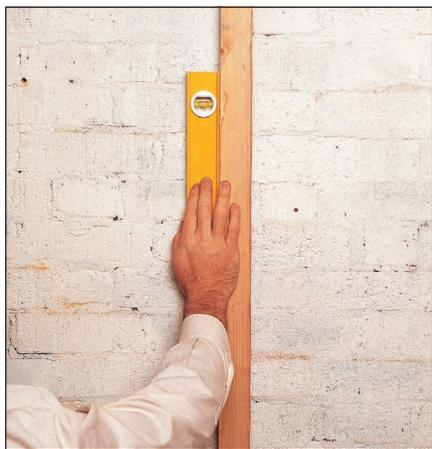
**1** Сначала прикрепите к стене гаража стойки, которые формируют отдельные секции. Перед креплением установите стойки вертикально.
