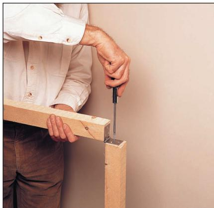
**3** Соберите рамы, разделяющие отдельные секции. Соединяйте детали гвоздями. Добавьте перекладины, которые послужат опорами для полок или пластиковых выдвижных ящиков.
