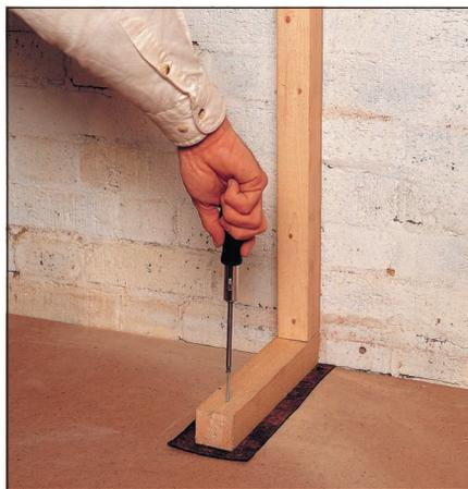
**2** Установите нижние перекладки на гидроизолирующие прокладки (на иллюстрации — листовый винил) и прикрепите их шурупами к полу гаража, предварительно высверлив там отверстия и вставив дюбеля.
