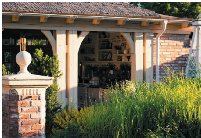
Кирпичные стены беседки находят свое продолжение в колоннах в саду
